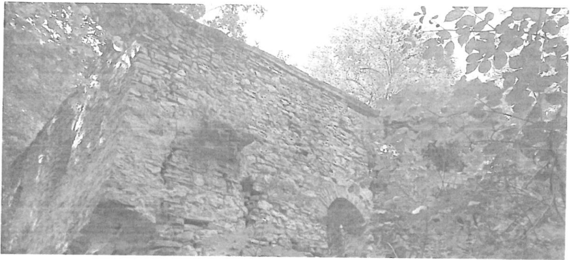
Malomépület keleti homlokzata az üzemi bejárattal (felül)
